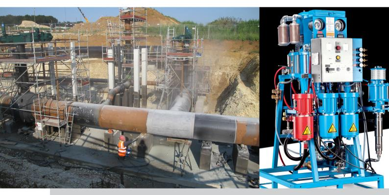
OIL & GAS ON FIELD PIPE COATING / ON FIELD JOINT COATING
